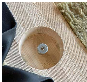
Bild 19: Beispiel Topfbohrung in einer CLT-Schmalseite
